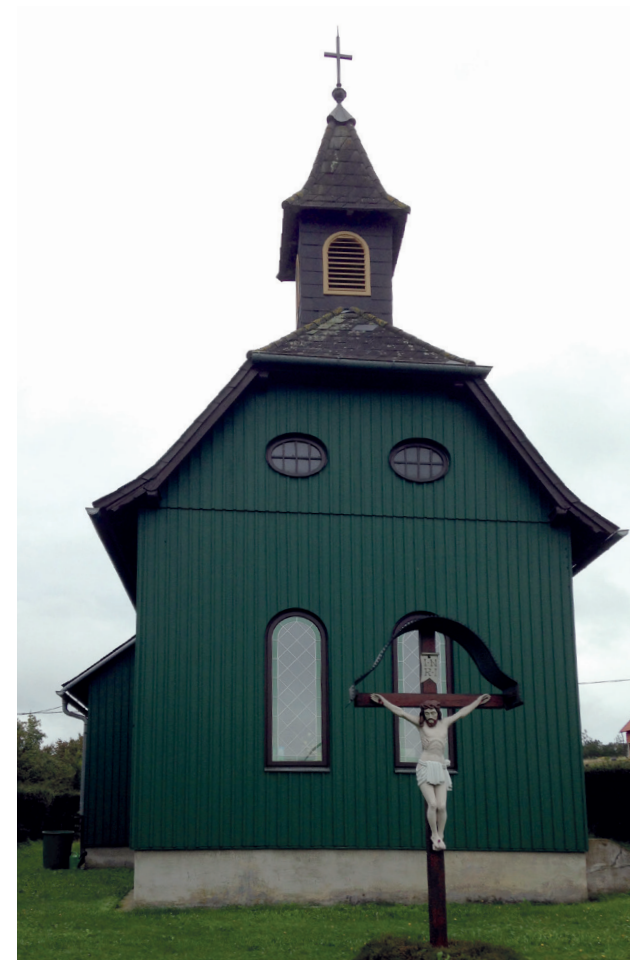
Abb. 4: Die Ostfassade des evangelischen Christuskirchleins mit dem Dachreiter darüber.
